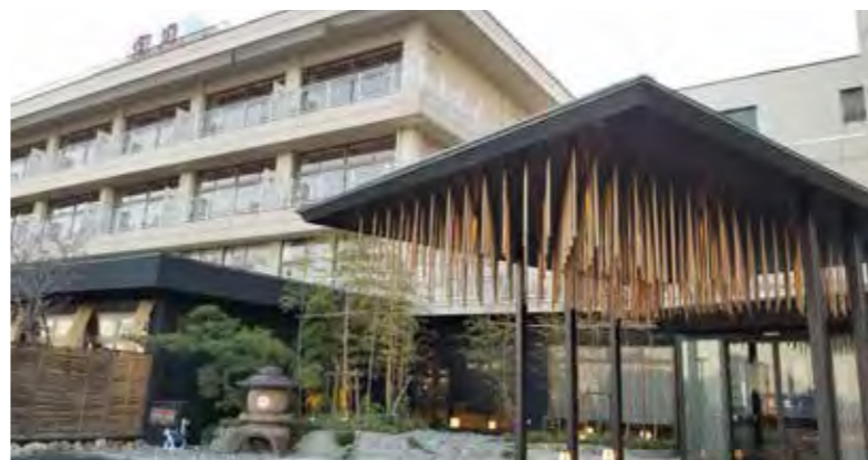
落ち着いた雰囲気のエントランス。敷地内には「湯屋 夢たまたま」があり、宿泊客は無料で利用できる
