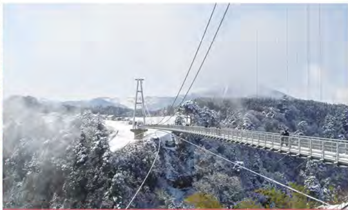
2 | 九重“夢”大吊橋:九重町大字野田1208 雪景色:2月頃
