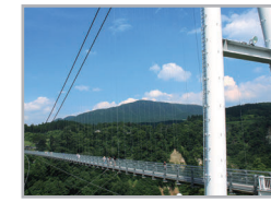
九重夢大吊橋
