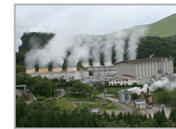
八丁原地熱地熱発電所 地熱学習
